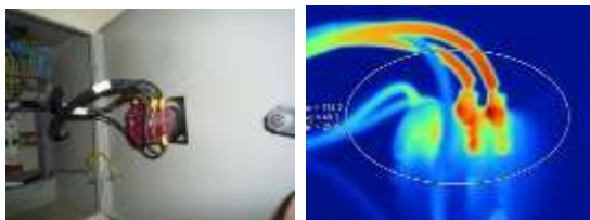
Slika 4. Pregrevanje kontakata na grebenastom prekidaču [15]
